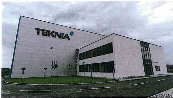
Fotografía 2: Nuevas instalaciones de TEKNIA Kragujevac
